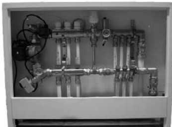
Распределительная система на базе узла DUAL MIX
